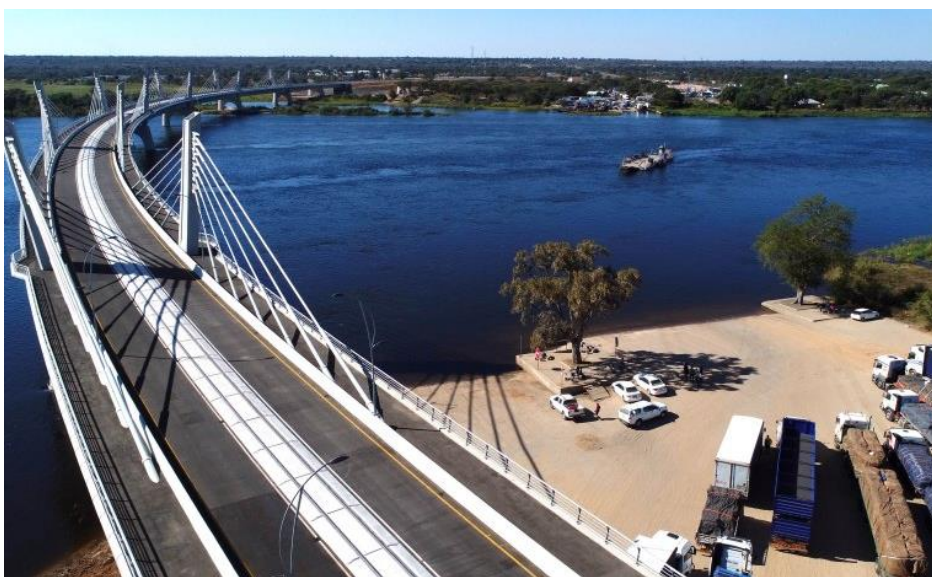
Photo : Le pont de Kazungula. Source : Ministère des Transports et des Communications, République du Botswana
